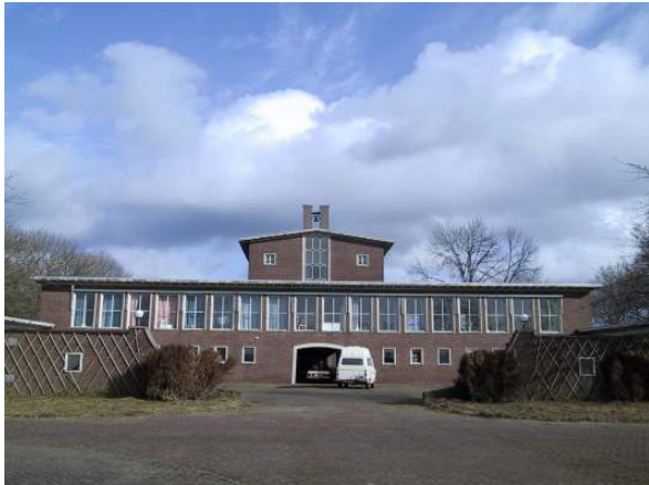
De achterzijde van het voormalige IVT, inmiddels gesloopt.
