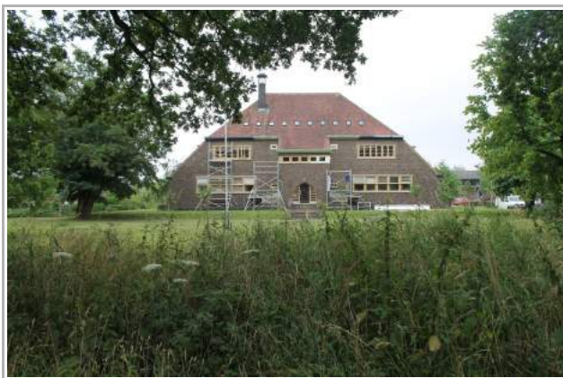
Uitvoering van het schilderwerk aan het voormalige Laboratorium voor Tuinbouwplantenteelt. Foto René Siemens)
