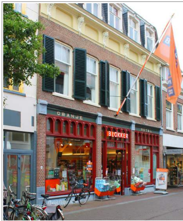
Het voormalige Oranjehotel in de Hoogstraat, voorbeeld van een zeer geslaagde restauratie (foto René Siemens)
